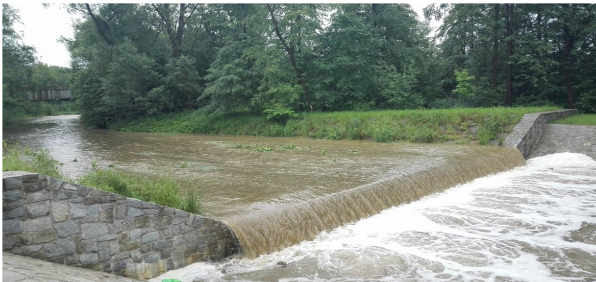
Obr. 6: Pohled na rozvodněnou řeku Stonávku (Třanovice) Zdroj: David Gorný / vlastní foto
