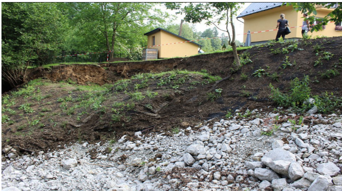
Obr. 14: Část sesunutého svahu v Havířově (3. červen 2018) Zdroj: Karvinsky.denik.cz (2018)
